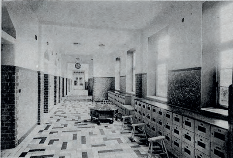
Schuhputzraum mit wahllos verlegtem Fliesenfußboden, abblendend gegen vorübergehende Beschmutzung, mit Schuh-schränken, Schuhanziehböcken und Schuhputzrondel.
