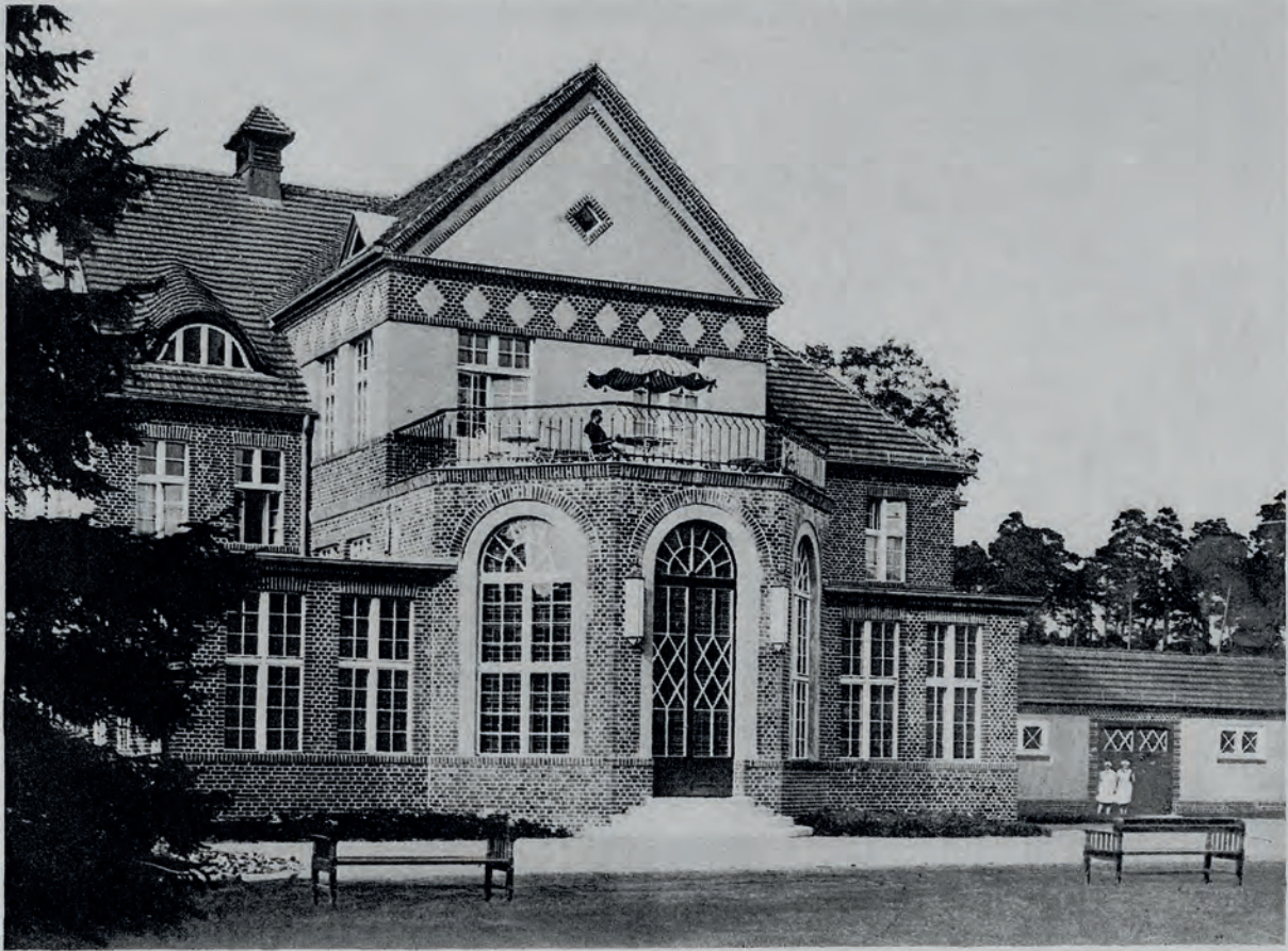
Im Verwaltungsgebäude befindet sich, vom Rondel zugänglich, der Saal. Er dient zunächst als Speisesaal für fast 300 Kranke, die hier zentralisiert ihre Mahlzeiten erhalten, während andere Krankengebäude dezentralisierte eigene Speiseräume aufweisen. Er dient weiterhin als Festsaal für die künftig insgesamt 550 Personen umfassende Belegschaft an Kranken und Anstaltspersonal. Über dem Saal, in günstigem Anschluß an die ihm benachbarten Küchenräume, liegen die Kasinoräume für oberes und mittleres Anstaltspersonal.
