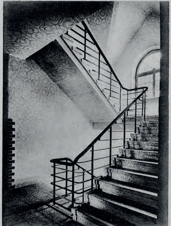
Die Treppenhäuser in Kunststein mit Härtezusatz haben einfache, leicht säuberbare, schmiedeeiserne Treppengeländer.
