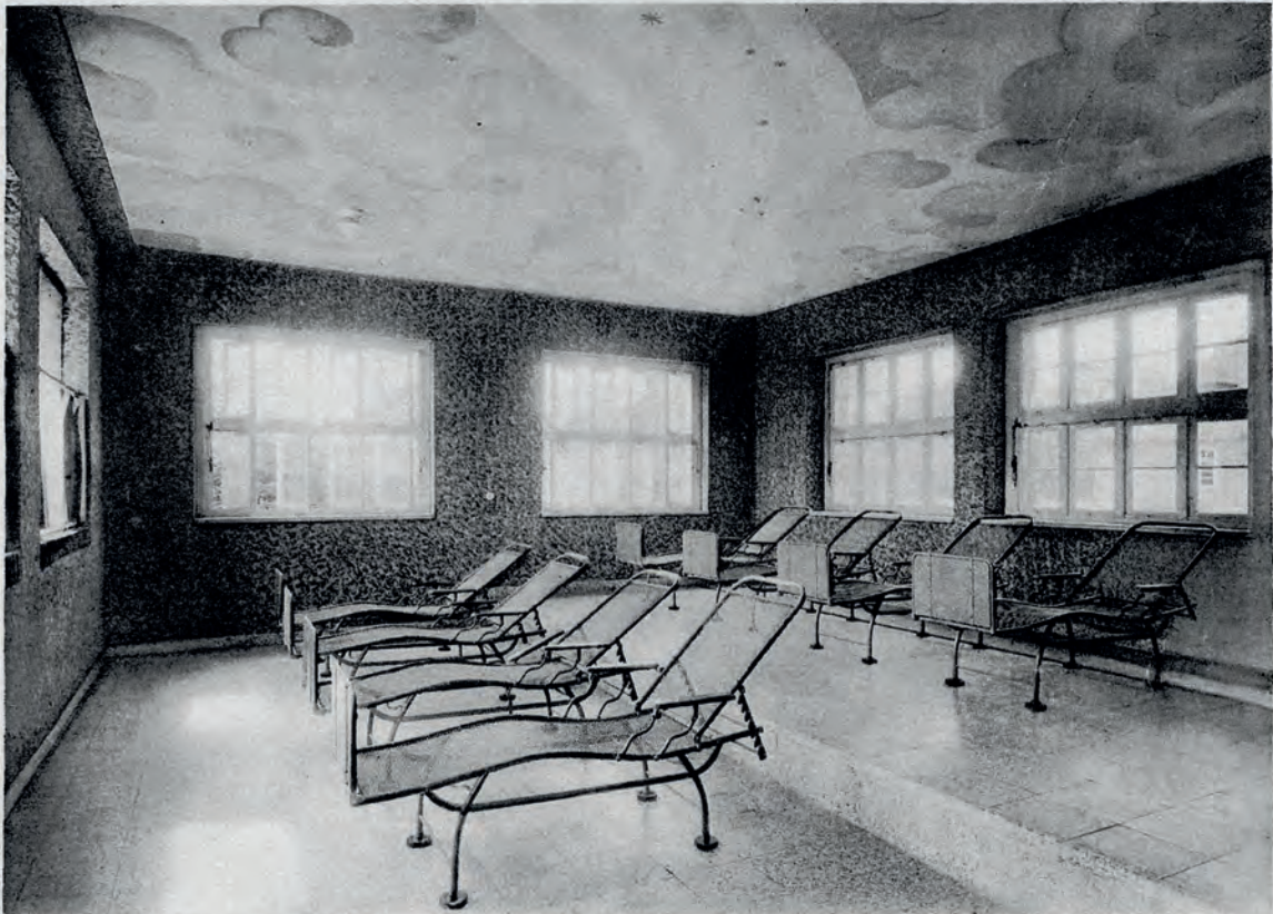
Diese Liegegestelle sind zweistufig, damit auch die hinteren Liegebetten ungehindert Luft und Ausblick erhalten. Von den nach drei Himmelsrichtungen gerichteten Fensteröffnungen sind die nach Süd gelegenen offen und mittels halbhoher Schleudervorhänge abblendbar. Die übrigen sind mit gekuppelten Wendefenstern versehen und ermöglichen bis 100prozentige Öffnung und Durchlüftung ohne Zugluft.
