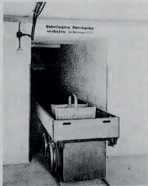
Die Elektro-Untergrundbahn fährt zwischen Verwaltungsgebäude und Südgebäude, ohne Begleitpersonal, durch einen Tunnel, wobei sie sich an beiden Seiten vor den Speiseaufzügen, selbsttätig ausschaltet.
