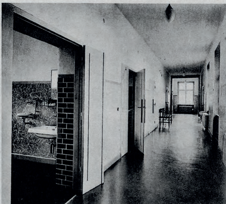
Die von den Krankenzimmern zu den breiten Korridoren führenden Zimmertüren sind zweiflügelig ungleich breit. Der breite Türflügel dient für Durchgang, mit zusätzlich schmalem Türflügel für Bettendurchfahrt.
