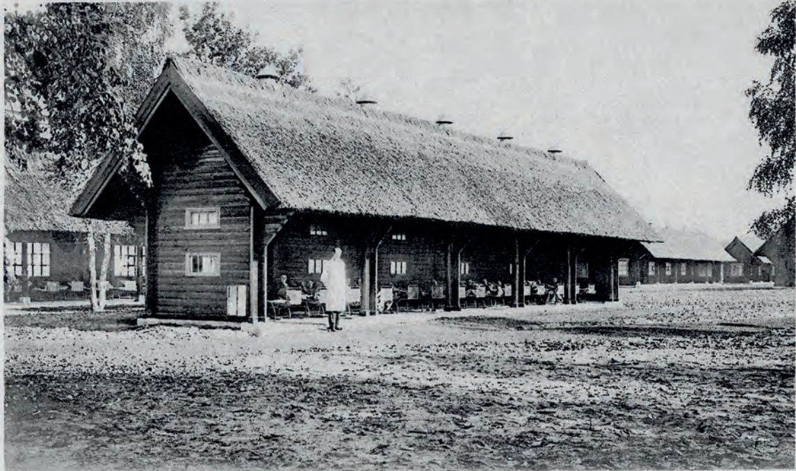
Die Liegehallen im Blockbau mit Schilfrohrdach haben sich gegen Hitze und Kälte besser bewährt als die vielfach angeratenen in massiver Glasbauweise. Sie fügen sich auch infolge ihrer primitiven Farbstellung gut in das Landschaftsbild. Rundfunkempfangsanlagen schaffen den Kranken die als Heilfaktor nötige Ruhe, weil jede laute Unterhaltung verstummt, sobald die Lautsprecher angestellt werden.
